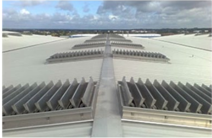
การติดตั้งช่องระบายควันบนหลังคาของอาคารโรงงาน
